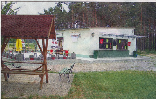
Gaststätte und Kiosk am Waldbad. Auch hier wurde in den vergangenen Wochen einiges erneuert.
