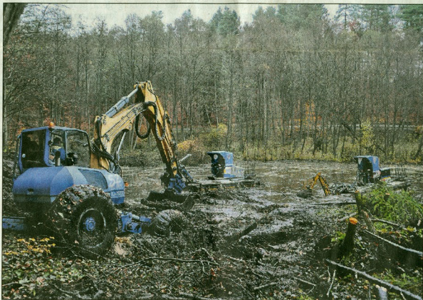
Auch wenn schwere Maschinen Wald und Wasser umpflügen: Hier ist keine Umweltzerstörung im Gange, sondern eine Gewässersanierung. Foto: Henke
